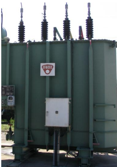
Figura 7.21. Arrefecimento tipo ONAN.
